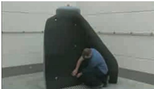
5. Fest start og slutt av isoleringsmantelen på limbåndet plassert under punkt I. Lim det andre limbåndet over sømmen der isoleringsmantelen møtes.
